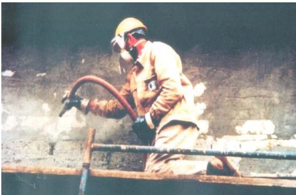
*Рис. 22. Очистка поверхности с помощью пескоструйной установки*
