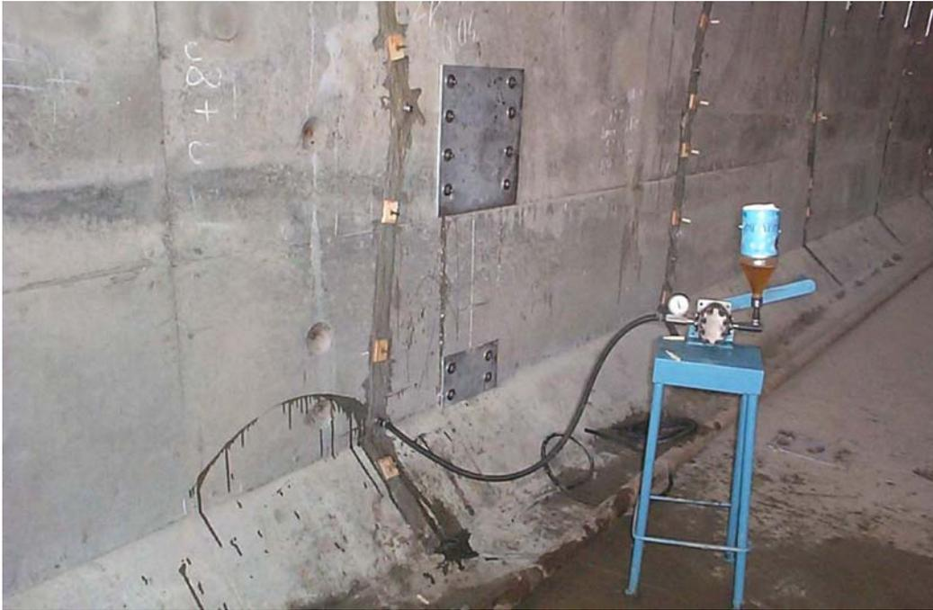
*Рис. 33. Инъектирование трещин по высоконапорной технологии*
