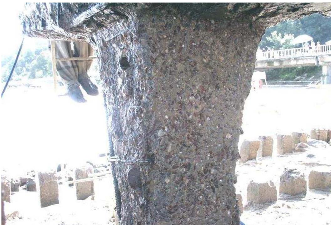
*Рис. 19. Бетонная опора, подготовленная к ремонту*
