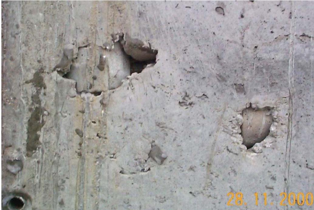
*Рис. 5. Зависание бетонной смеси в зоне «сухарей»*
