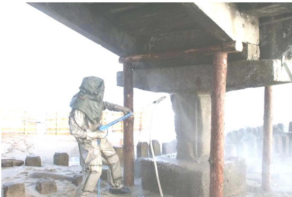
*Рис. 21. Очистка поверхности бетона помощью водопескоструйной установки*
