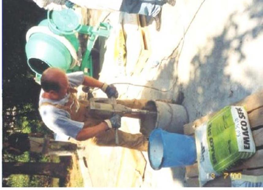
*Рис. 12. Приготовление ремонтных смесей ЭМАКО на различном оборудовании:
