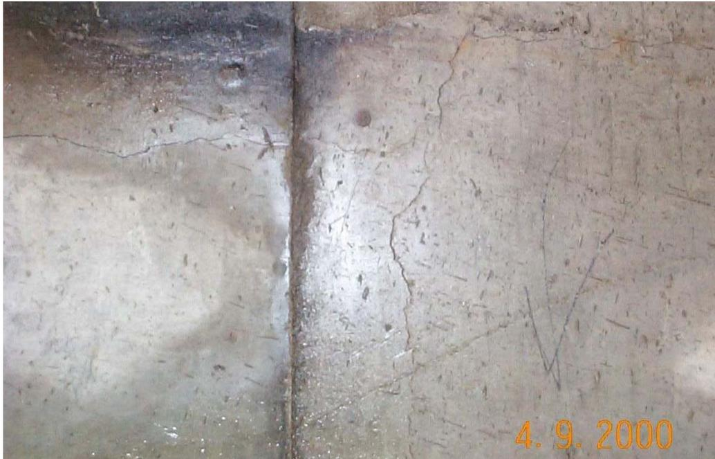
*Рис. 6. Усадочные трещины на поверхности стены секции № 8
