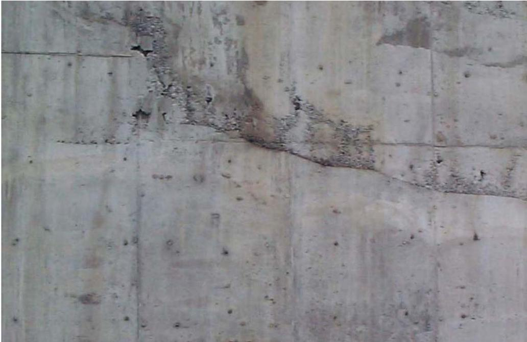
*Рис. 3. Щебенистость на поверхности стены и полости, незаполненные бетоном*
