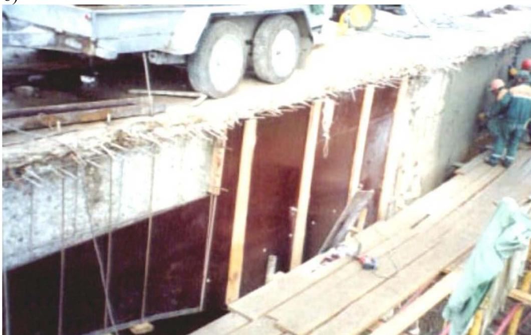
*Рис. 25. Нанесение ремонтного состава методом набрызга:
