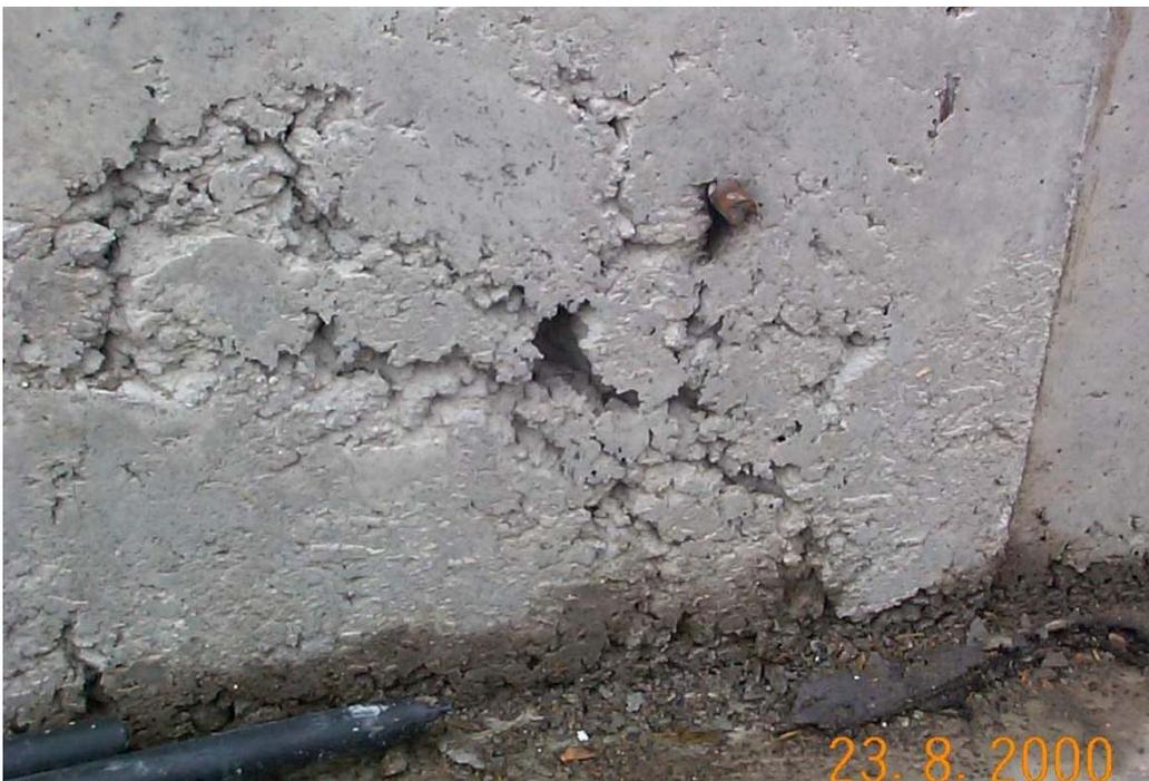
*Рис. 4. Непровибрированные участки стены*
