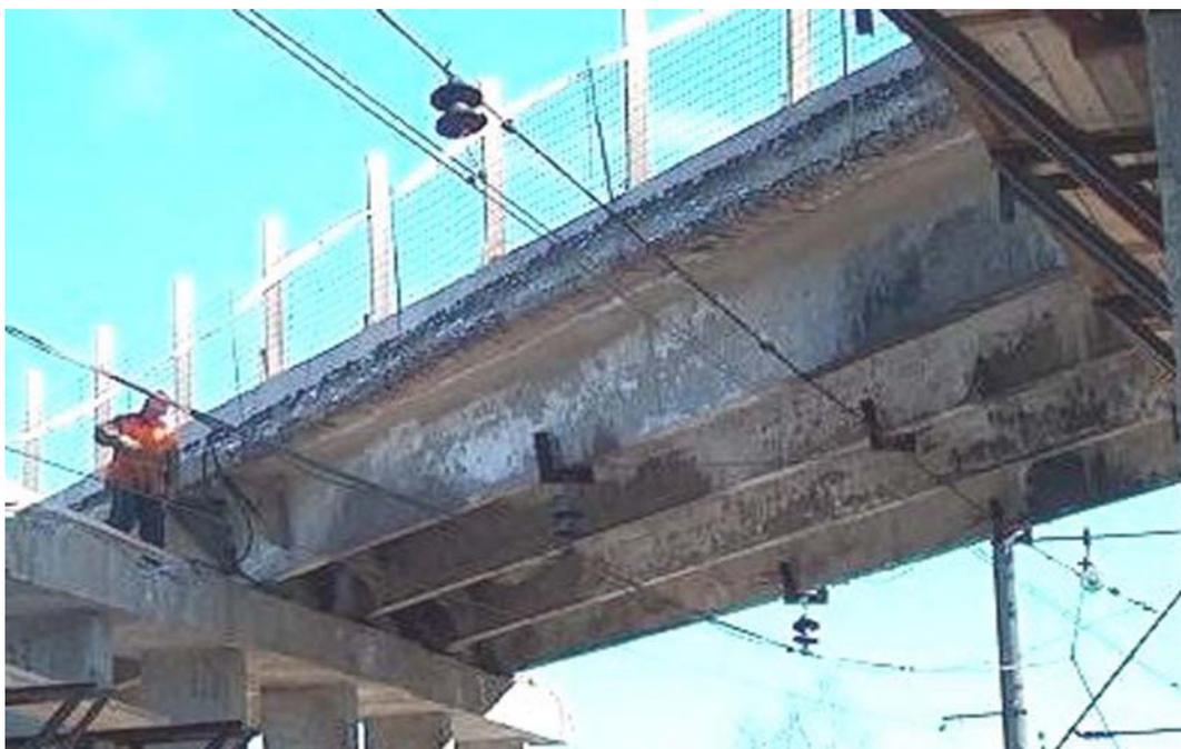
*Рис. 7. Разрушение бетона пролетного строения*
