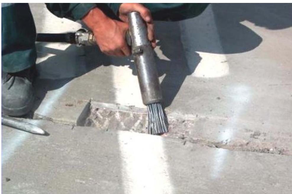
*Рис. 14. Подготовка бетона игольчатым пистолетом*
