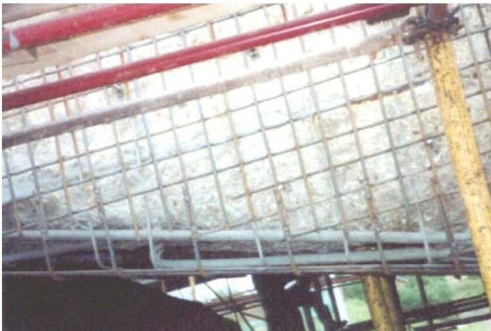
*Рис. 23. Восстановление несущей способности балки с помощью дополнительного армирования*
