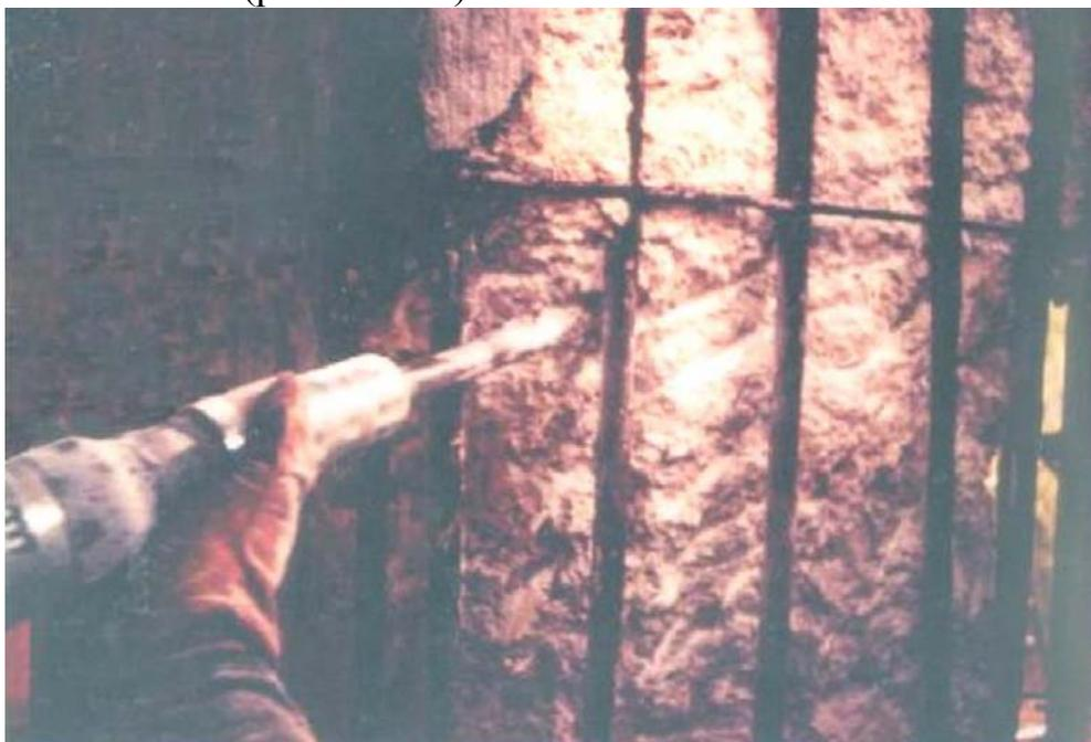
*Рис. 13. Подготовка поверхности с помощью бучарды*
